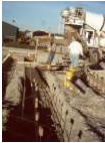
Foundation Concrete Pour
